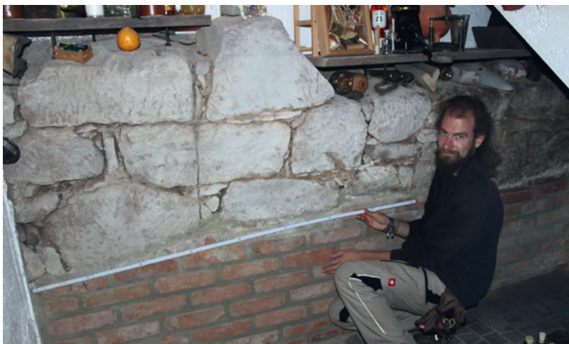
Abb. 5 Massiver Fundamentsockel der ehemaligen Stadtmauer, der bei einer Kellererweiterung 1990 zum Vorschein gekommen ist (Foto: CAU zu Kiel/F. Jürgens).
