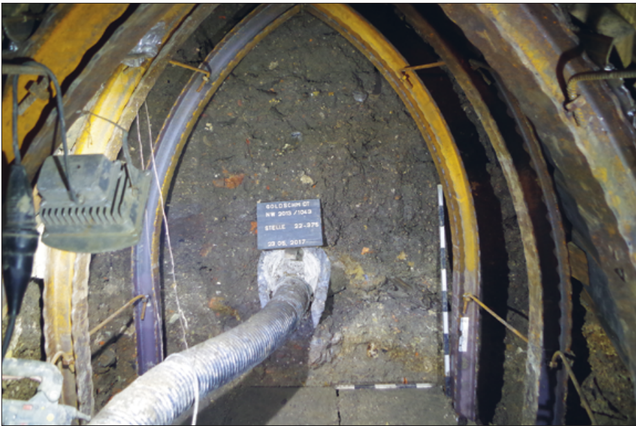
Abb. 1 Aachen, Tunnelgrabung NW 2013/1043. Blick in den unterirdisch durchgeführten Vortrieb. – (Foto J. Meffert, Firma Goldschmidt Archäologie und Denkmalpflege).
