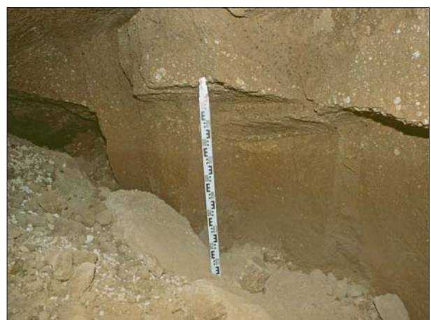
Abb. 5 Meurin 5. Kammer 2 im November 1999: Die Abbaukammer ist hoch mit altem Versatz verfüllt. – (Foto VAT).
