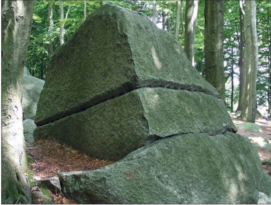
Abb. 18 Felsenmeer, Odenwald (Kreis Bergstraße). Felsblock mit gepickter Keilnut (Typ 2) und in gleichmäßigen Abständen eingearbeiteten Keiltaschen (Typ 5) zur Vorbereitung einer Felspaltung. – (Foto Von StromBer – Eigenes Werk, CC BY 3.0, https://commons.wikimedia.org/w/index.php?curid=4604319 ).
