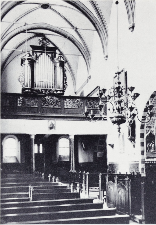
Abb. 20 Die Orgelemporeanlage im Zustand des XIX. Jahrhunderts
