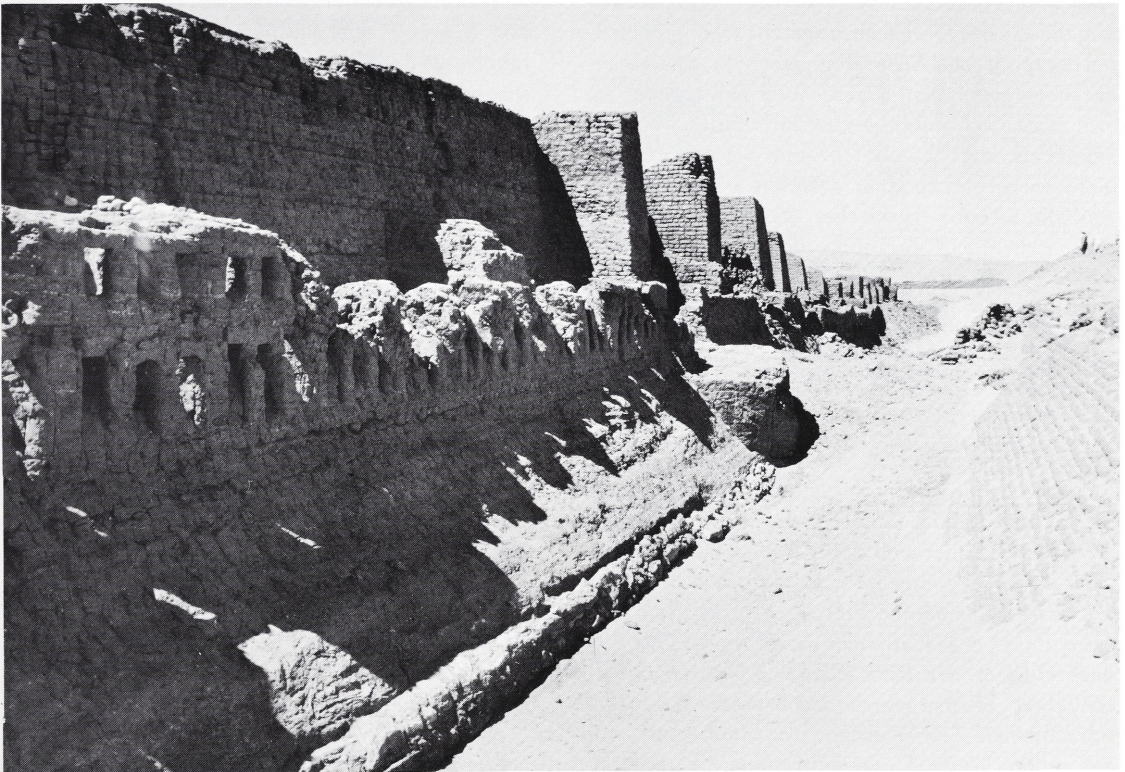
Abb. 3 Bub'en (oberhalb des II. Katarakts) (Festung des Mittleren Reiches)
