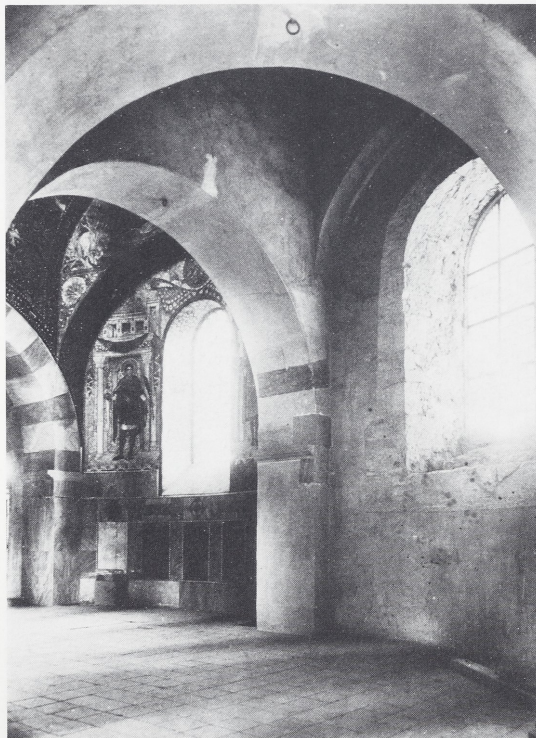
Abb. 9 Blick in den oberen Umgang, provisorische Hängung einiger Entwürfe
