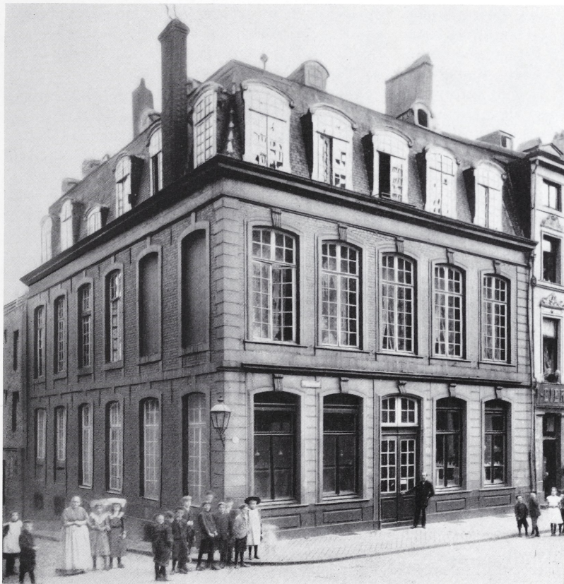
Abbildung 3: Haus Monheim, Zustand vor dem Ladeneinbau um 1890
