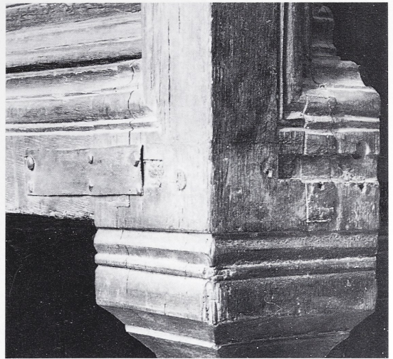
Abb. 3 Verbindung der Balken und Stollen mit Eisen gesichert, diese von Kupferblechen verdeckt
