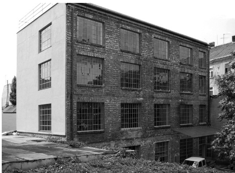
Abb. 1: Außenansicht Brick-5. Foto: basis wien
