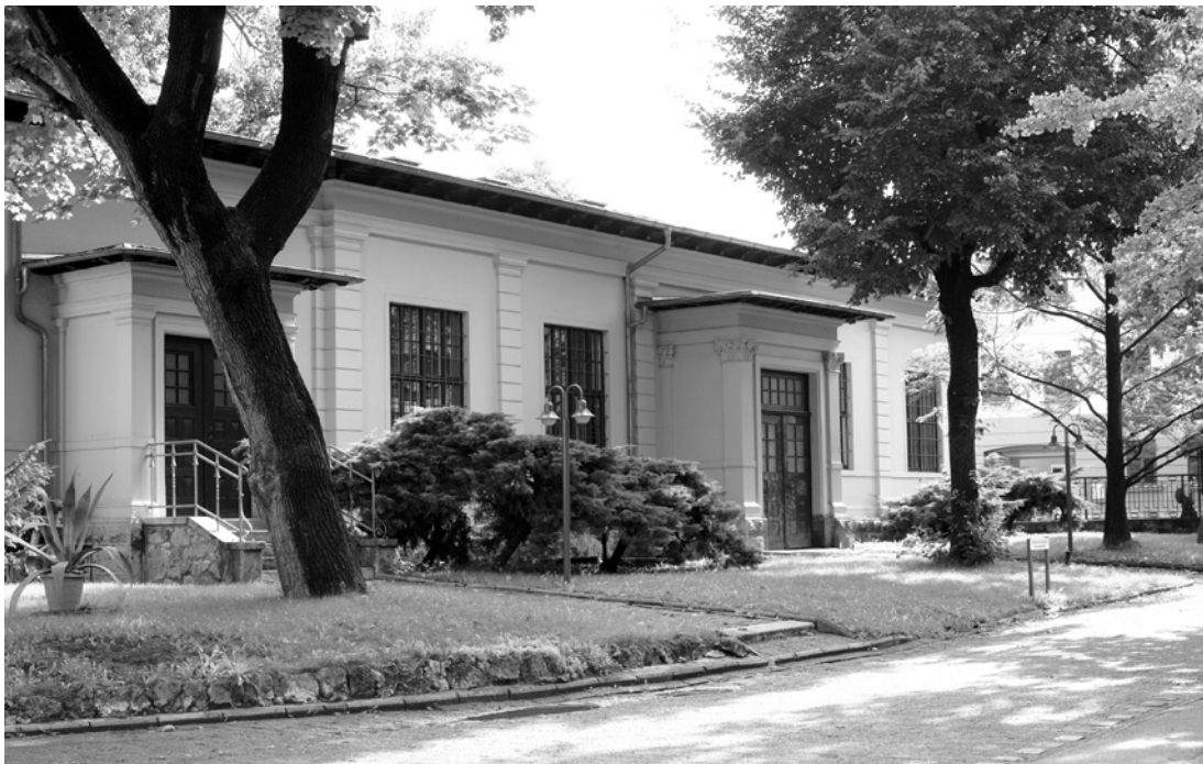
Abb. 4: Donndorf-Gebäude mit den Sammlungsbereichen des TLDA. Foto: TLDA, M. Hartung
