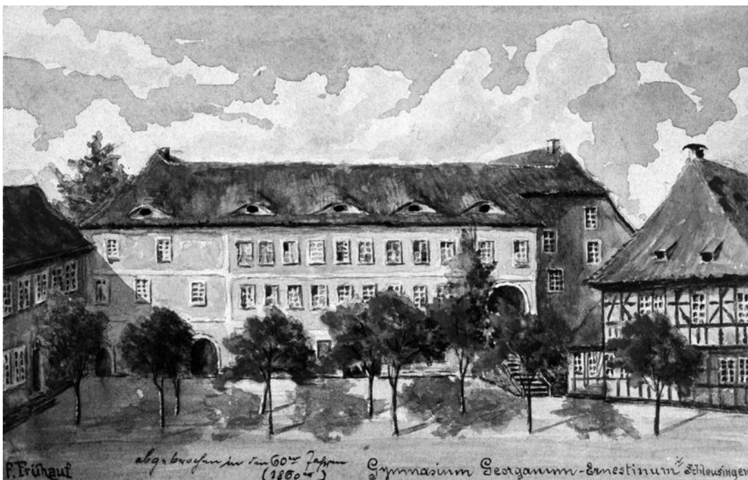
Abb. 1: Das alte Gymnasium bis 1868, 1502 als Barfüßer-Kloster erbaut
