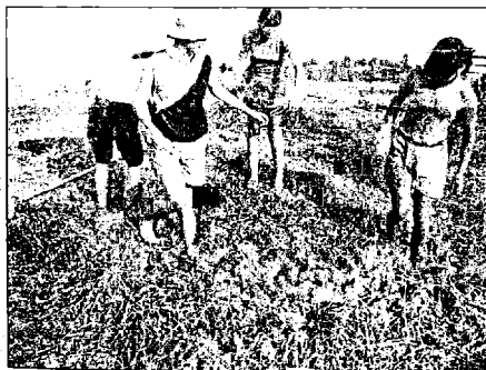
Fig. 30. Frământarea chirpicului (Foto V. Cotiuță).
