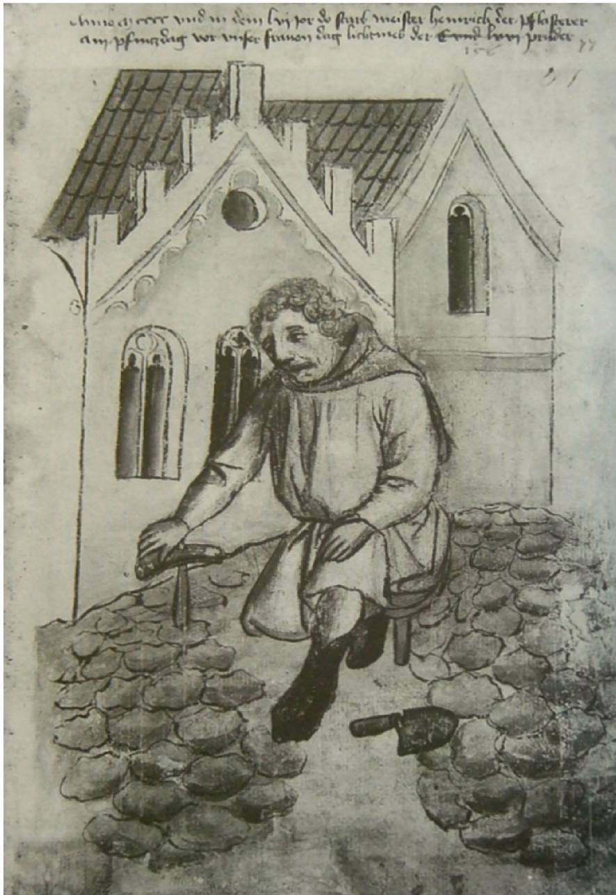
Pl. XXX. Drumar din Nürnberg care netezește patul de nisip cu mistria, așează piatra de pavaj în rânduri neregulate, apoi o bate cu coada ciocanului de pietrar. Circa 1425. Nürnberg, Stadtsbibliothek, Hausbuch der Mendelschen Zwölfbrüderstiftung , fol.70v (JARITZ 2001: 51).
