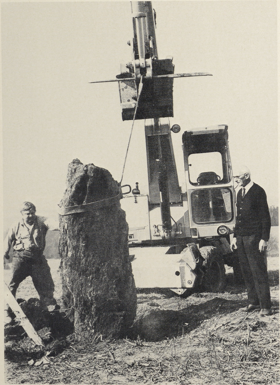
Abb. 3: Aufrichtung des Menhirs mit Bagger und Stahlseil (1971).
