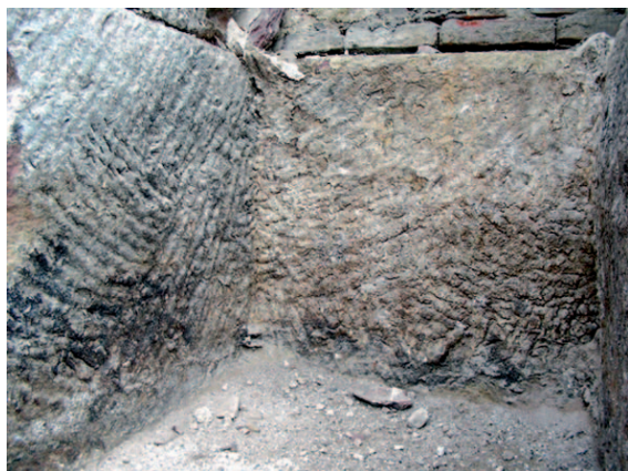
Abb. 3 Lahr (Ortenaukreis), städtisches Alten- und Pflegeheim „Spital“, Umbau 2009. Innenseiten des Steintrogs aus dem südlichen Spitalflügel mit bogenförmigen Spuren der Steinbearbeitung („Gardinschlagmuster“).
