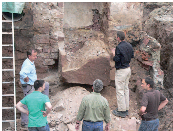
Abb. 1 Lahr (Ortenaukreis), städtisches Alten- und Pflegeheim „Spital“, Umbau 2009. Der erste, in der hofseitigen Nordwand des südlichen Spitalflügels vermauerte und mit Bauschutt verfüllte Steintrog unmittelbar nach seiner Entdeckung.
