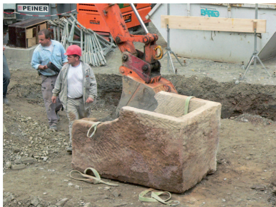
Abb. 2 Lahr (Ortenaukreis), städtisches Alten- und Pflegeheim „Spital“, Umbau 2009. Der aus dem Mauerverbund gelöste und vom Bauschutt befreite Steintrog aus dem südlichen Spitalflügel vor dem Abtransport.
