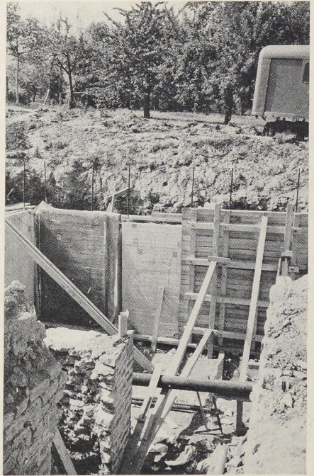
3. Blick durch den Treppenschacht auf die Südwand während der Einschalung.
