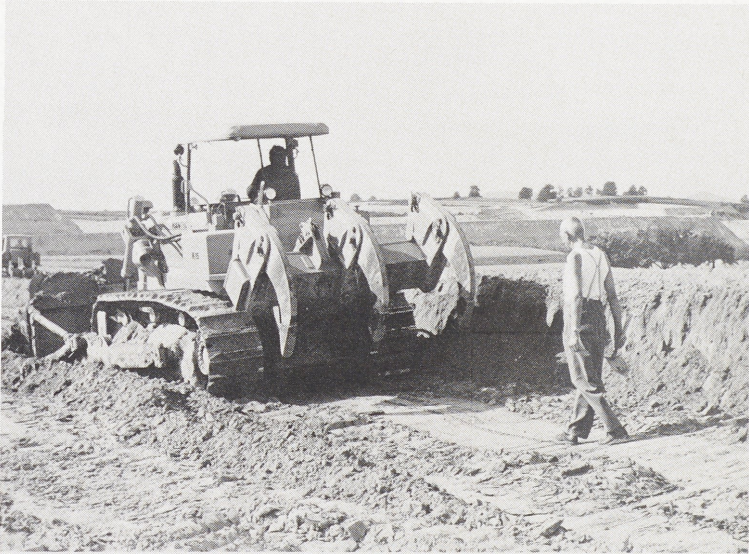
Abb. 3: Überwachung von Planierarbeiten in einem fundverdächtigen Gebiet.
