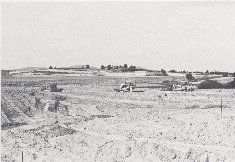
Abb. 1: Flächenplanierung auf Gemarkung Munzingen (Freiburg).
