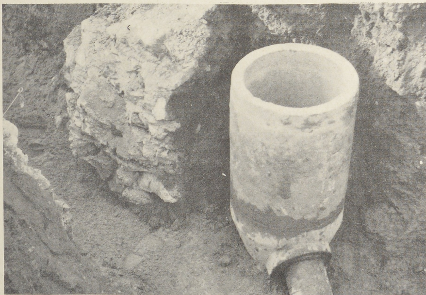
Abb. 4: Ein den Baggergraben querendes Mauerstück mußte mit dem Preßlufthammer durchgeschlagen werden. Daneben ein moderner Betonrohrsammler der Regenwasserleitung.
