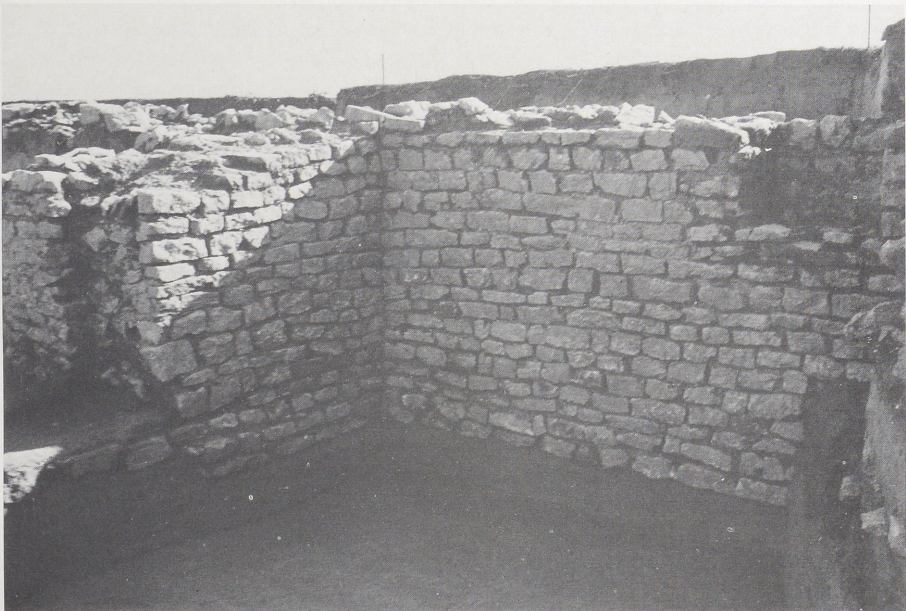
Abb. 3: Blick auf die Südostecke des Kellers. Rechts oben die freigelegte Wandnische.
