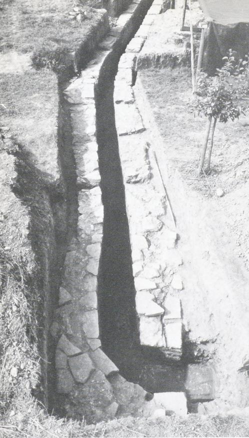
Abb. 11: Neckarburken, Gem. Elztal, Neckar-Odenwald-Kreis; römisches Militärbad. Hauptabwasserkanal des Bades; die im Hintergrund noch gut sichtbaren Schlitz in der Krone des Mauerwerks dienen zur Aufnahme der Querbalken für die hölzerne Abdeckung.
