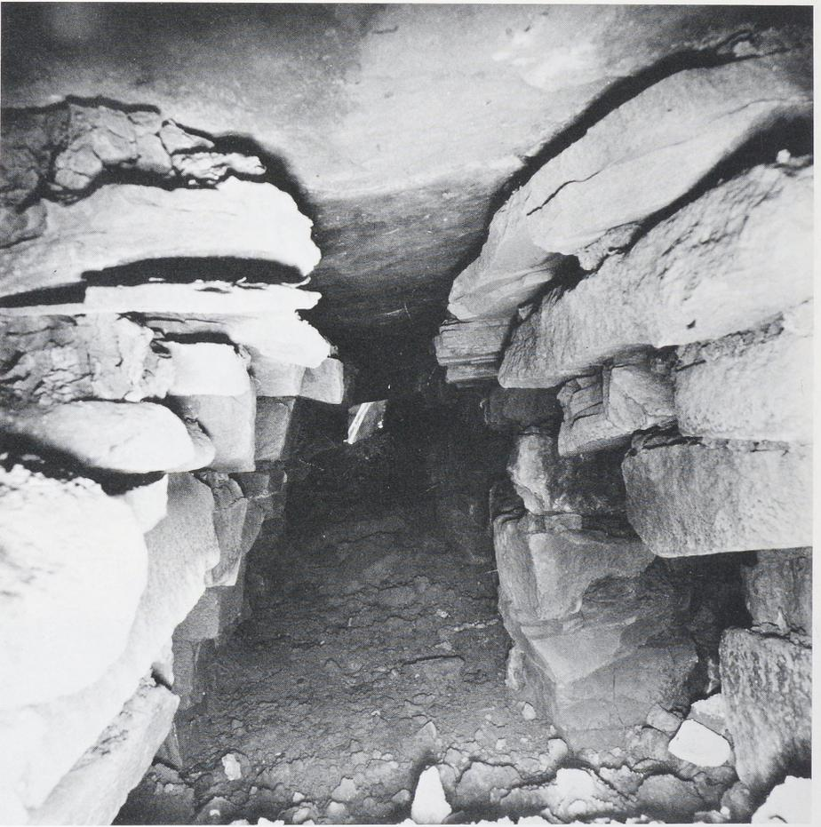
Abb. 9: Neckarburken, Gem. Elztal, Neckar-Odenwald-Kreis; römisches Militärbad. Blick in die fast völlig intakte Heizungsanlage des westlichen Sudatoriums (Zustand bei Auffindung).
