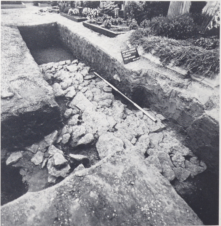
Abb. 5: Stettfeld, Gem. Ubstadt-Weiher, Lkr. Karlsruhe. Unterbau der römischen Fernstraße Heidelberg–Straßburg–Basel aus Sandsteinplatten.
