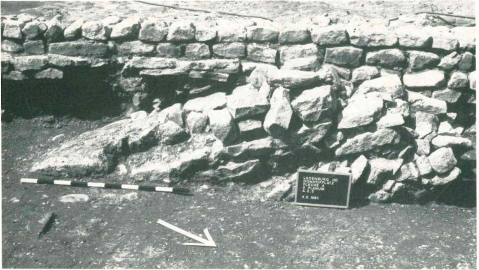
Abb. 24: Ladenburg, Rhein-Neckar-Kreis, Domhofplatz. Blick auf die freigelegte, in den Steinkastellgraben abgesunkene Mauer eines Gebäudes aus der römischen Zivilzeit.
