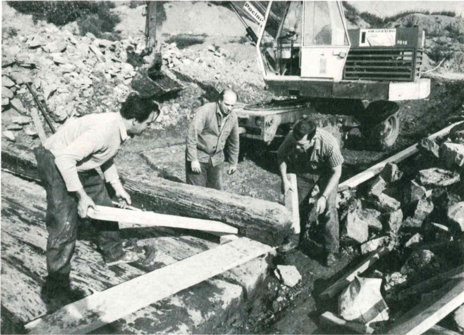
Abb. 2: Magdalenenberg. Bergen der Balken des Kammerbodens. Unterfangen der durch Feuchtigkeit weichen Bodenbalken mit Dielen.
