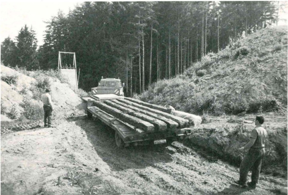
Abb. 3: Magdalenenberg. Abtransport von fünf Balken des Kammerbodens auf einem Tieflader.
