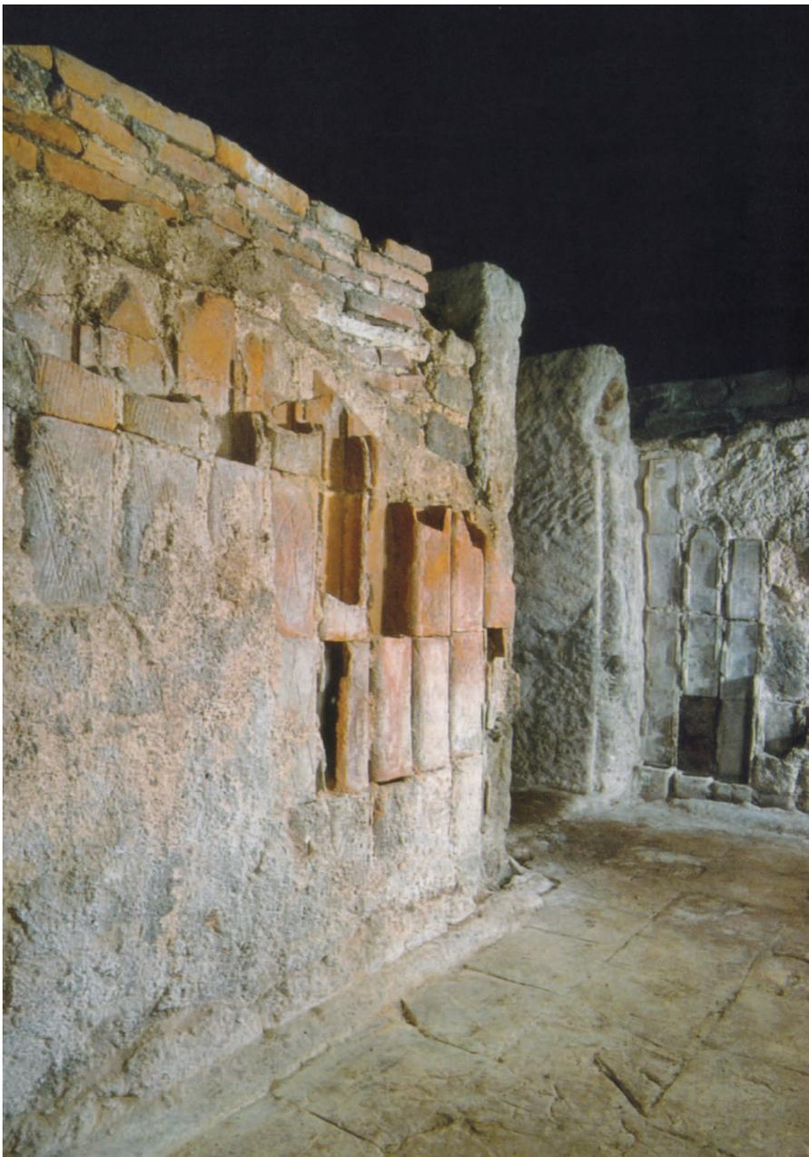
Abb. 11 „Soldatenbäder“ (Tepidarium). Außergewöhnlich gute Erhaltung vor allem der tubulierten Wände (Heiztechnik).
