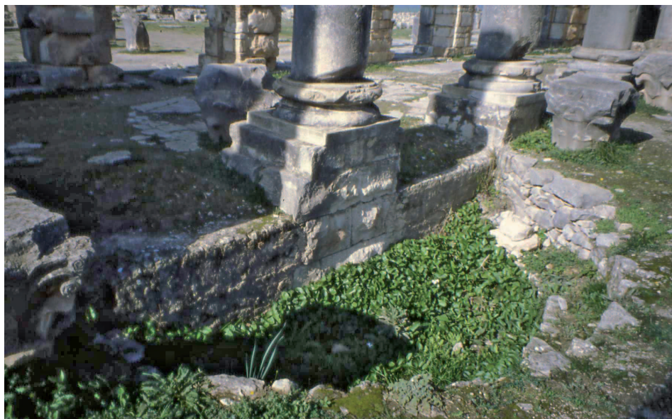
Abb. 5 Fundamentierung unter einer der Säulen der Basilika in Volubilis.
