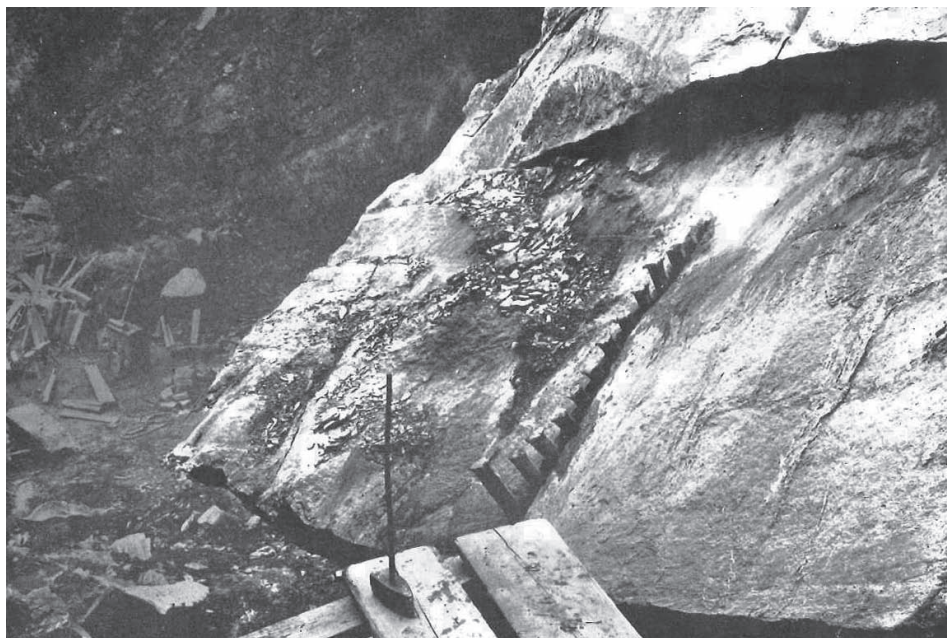
Abb. 3 Keilspaltung an einem Sandsteinblock in Bürgstadt bei Miltenberg. (Foto J. Röder, Taf. 4).
