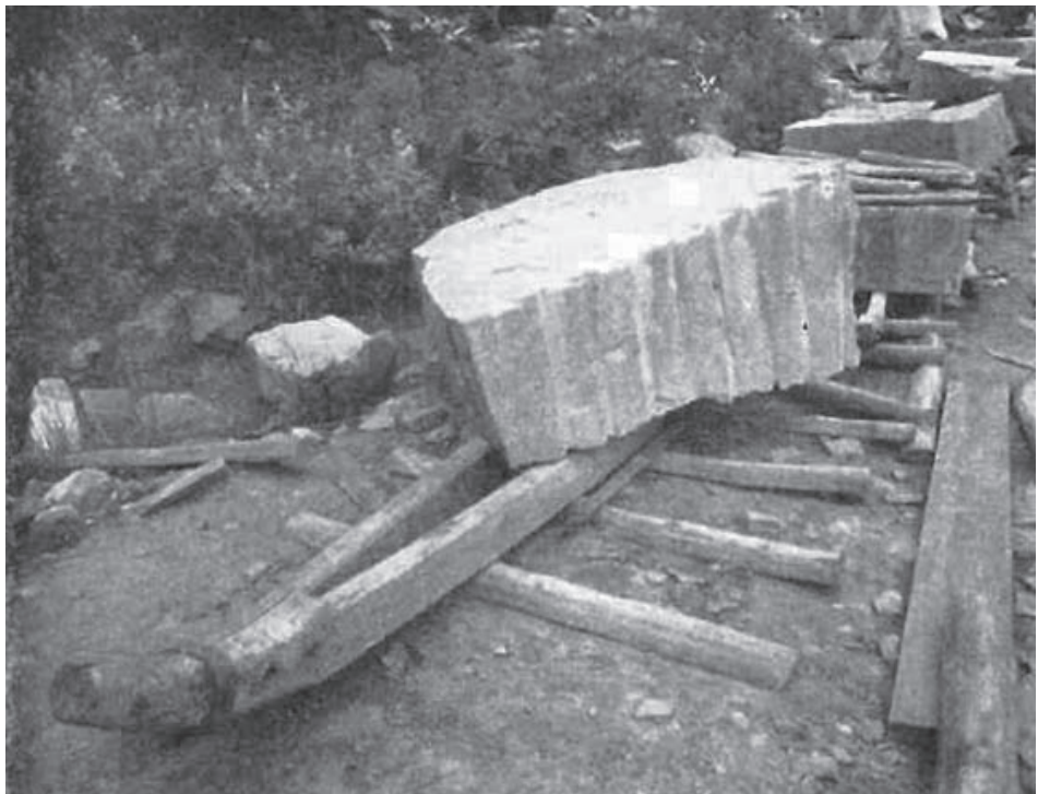
Abb. 6 Steinschlitten zum Transport aus dem Steinbruch in Bürgstadt (Foto J. Röder, Taf. 5).
