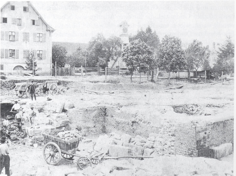
Abb. 1: Photographie der 1892 begonnenen Abrißarbeiten römischer Mauersubstruktionen. Im linken Bildhintergrund das heute noch stehende Pfarrhaus, welches zeigt, daß der jetzige Kirchenvorplatz etwa 4 m unter den römischen Laufhorizont abgetieft wurde.
