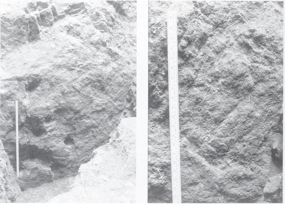
Abb. 5: Oberer Riestergang. Balkenwiderlager (1) und Schlägel-Eisen-Arbeiten (2) an den Wänden des ausgeräumten Verhaus.
