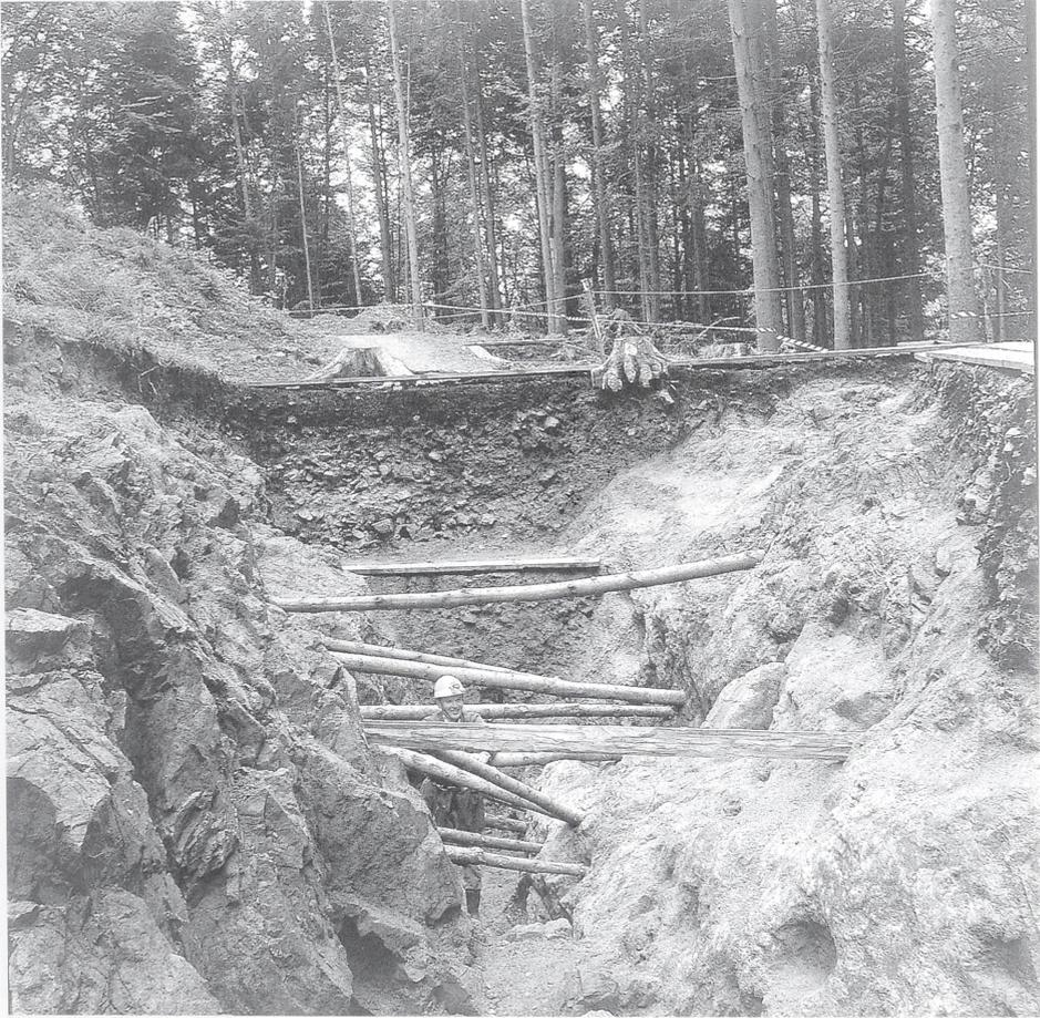
Abb. 4: Oberer Riestergang. Blick in den ausgeräumten Verhau mit den Balkenwiderlagern, markiert durch die modern eingefügten Baumstämme.
