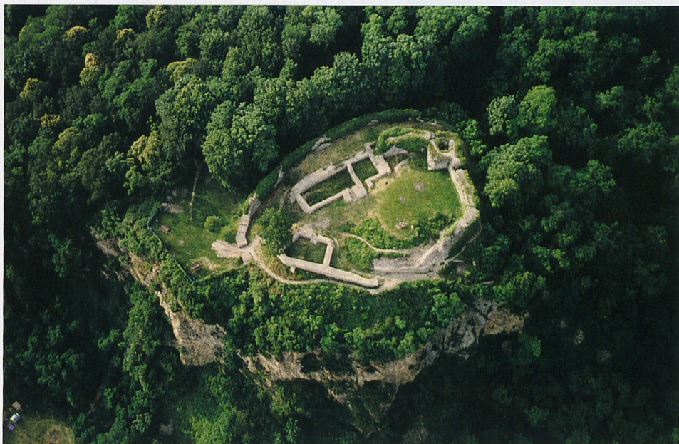
Abb. 1: Im Juni 1994 entstandene Luftaufnahme der Ruine Schauenburg bei Dossenheim an der Bergstraße von „Drachenflieger“ M. Black, Dossenheim.
