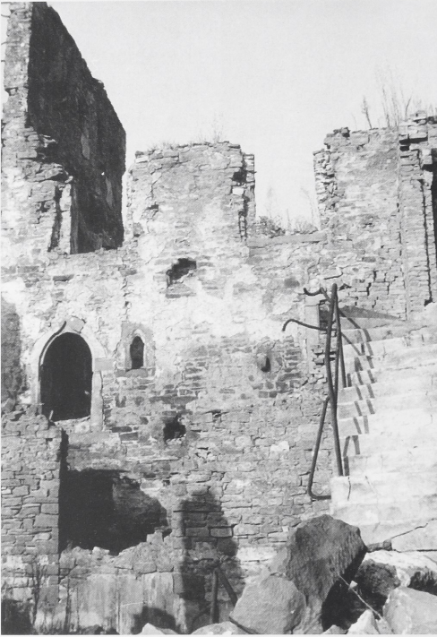
Abb. 3b Pforzheim. Ansicht des „Gotischen Hauses“ (um 1950).
