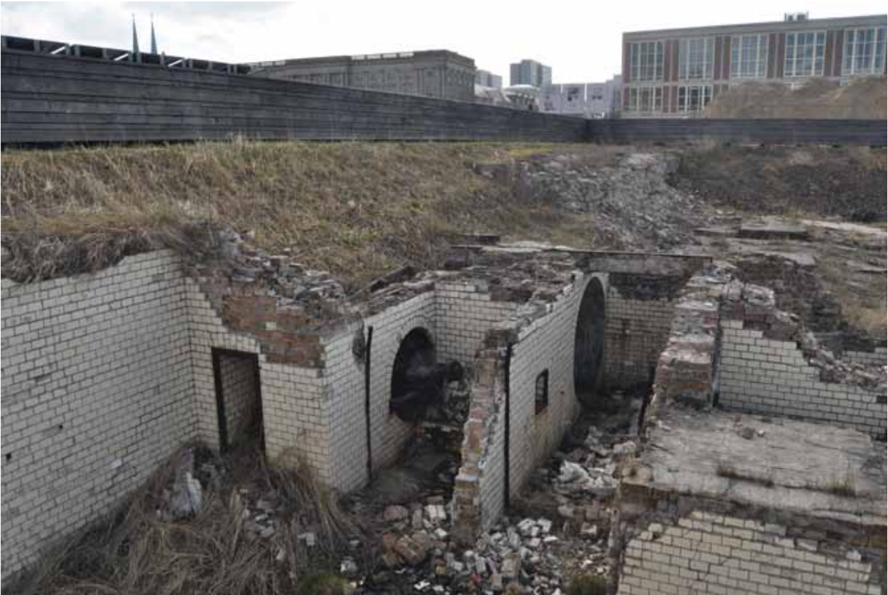
Abb. 2: Maschinenraum des Wilhelminischen Heizungskellers. Foto: Michael Malliaris.
