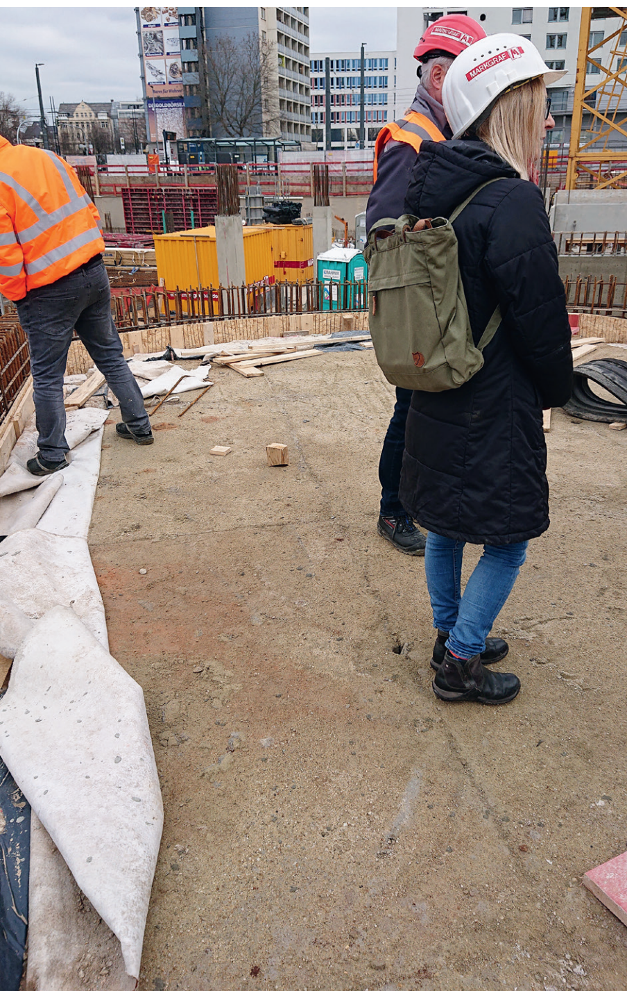
Abb. 11 Nach Abnahme des Betondeckels zeigt sich, dass der Erdmörtel unbeschadet ist. Das regelmäßige Schnittmuster auf der Oberfläche stammt vom Sägen des Betons, der in kleinen Stücken abgenommen wurde. Landesamt für Archäologie Sachsen. Foto: R. Wegener.
