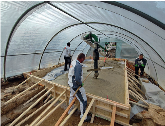
Abb. 7 Der verflüssigte Erdmörtel wird eingebracht. Landesamt für Archäologie Sachsen. Foto: P. Hiptmair.
