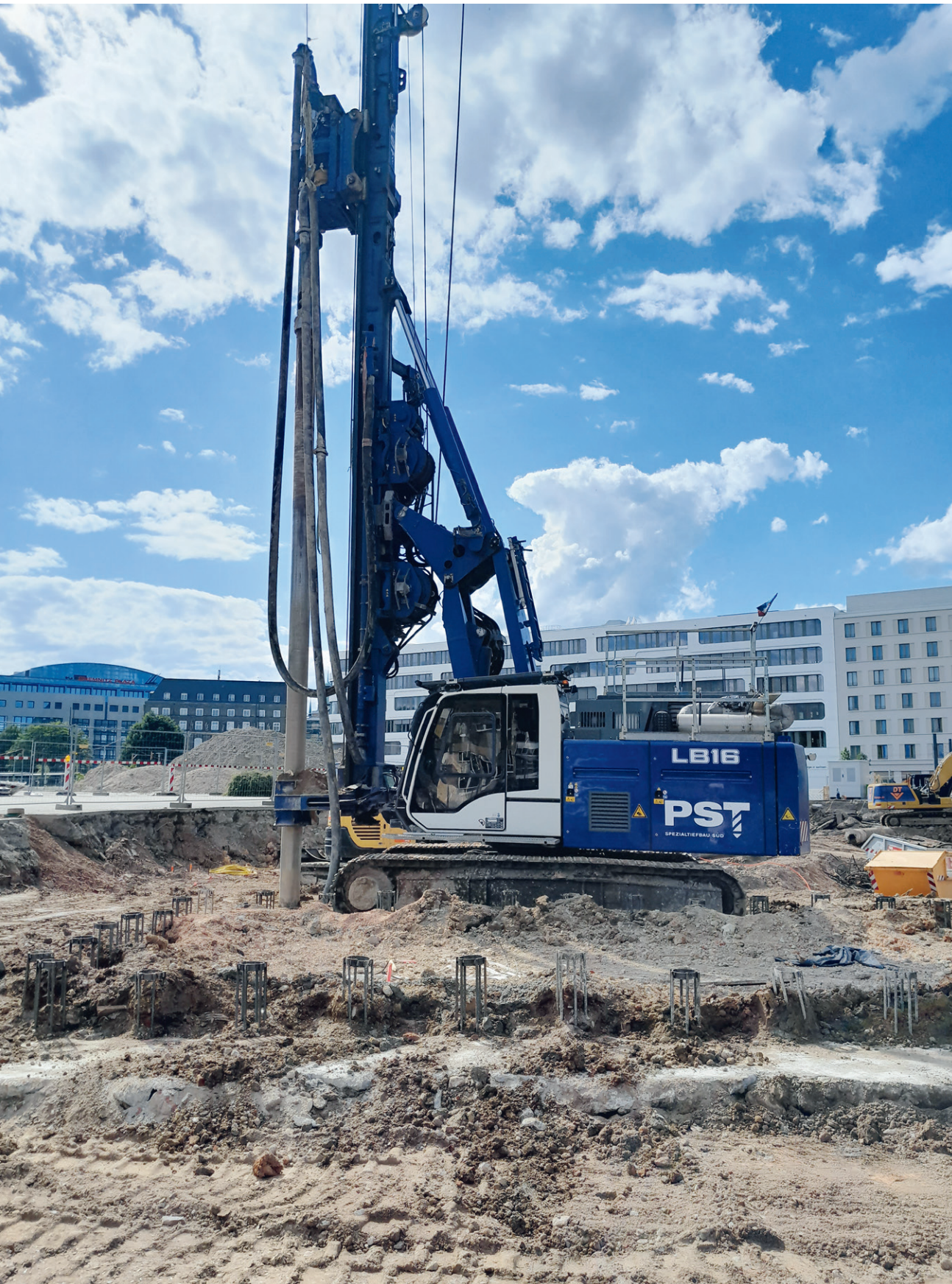
Abb. 9 Nach der Verfüllung wird die Mikwe mit Bohrpfählen umgeben, die den späteren Kokon bilden. Landesamt für Archäologie Sachsen. Foto: R. Wegener.
