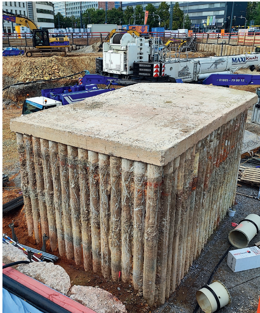
Abb. 10 Der fertiggestellte Kokon mit Betondeckel steht in der Baugrube. Er ist unten offen, so dass die Mikwe in ihrem natürlichen Umfeld verbleibt und nach wie vor wechselnden Grundwasserpegeln ausgesetzt ist. Die Arbeiten am Bau können ungehindert stattfinden. Landesamt für Archäologie Sachsen. Foto: P. Hiptmair.
