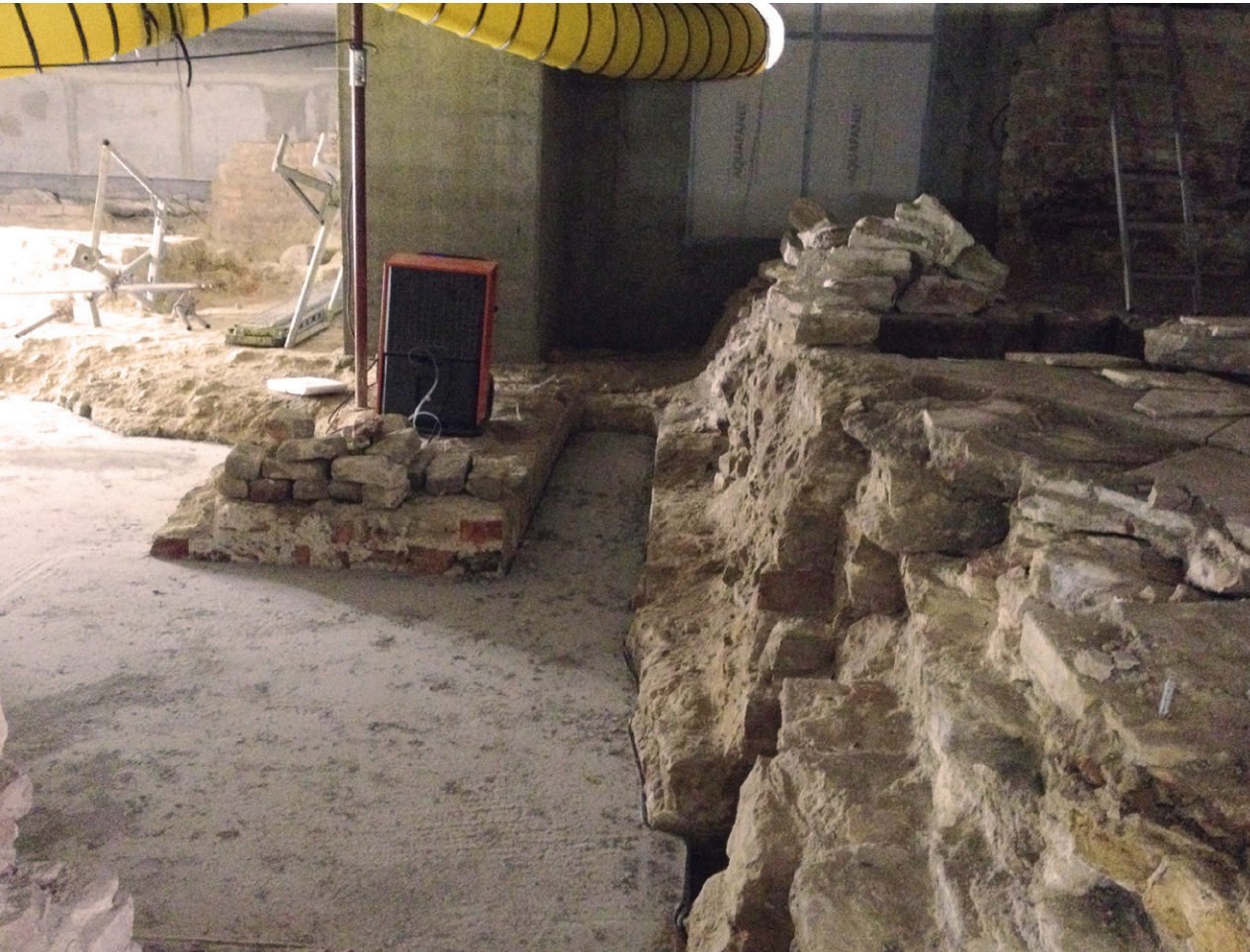
Abb. 9 Baustelle im Zwischenzustand mit eingebrachtem Betonboden, Kondensations-trocknern und Lüftungsschläuchen. Foto: U. de Maizière.
