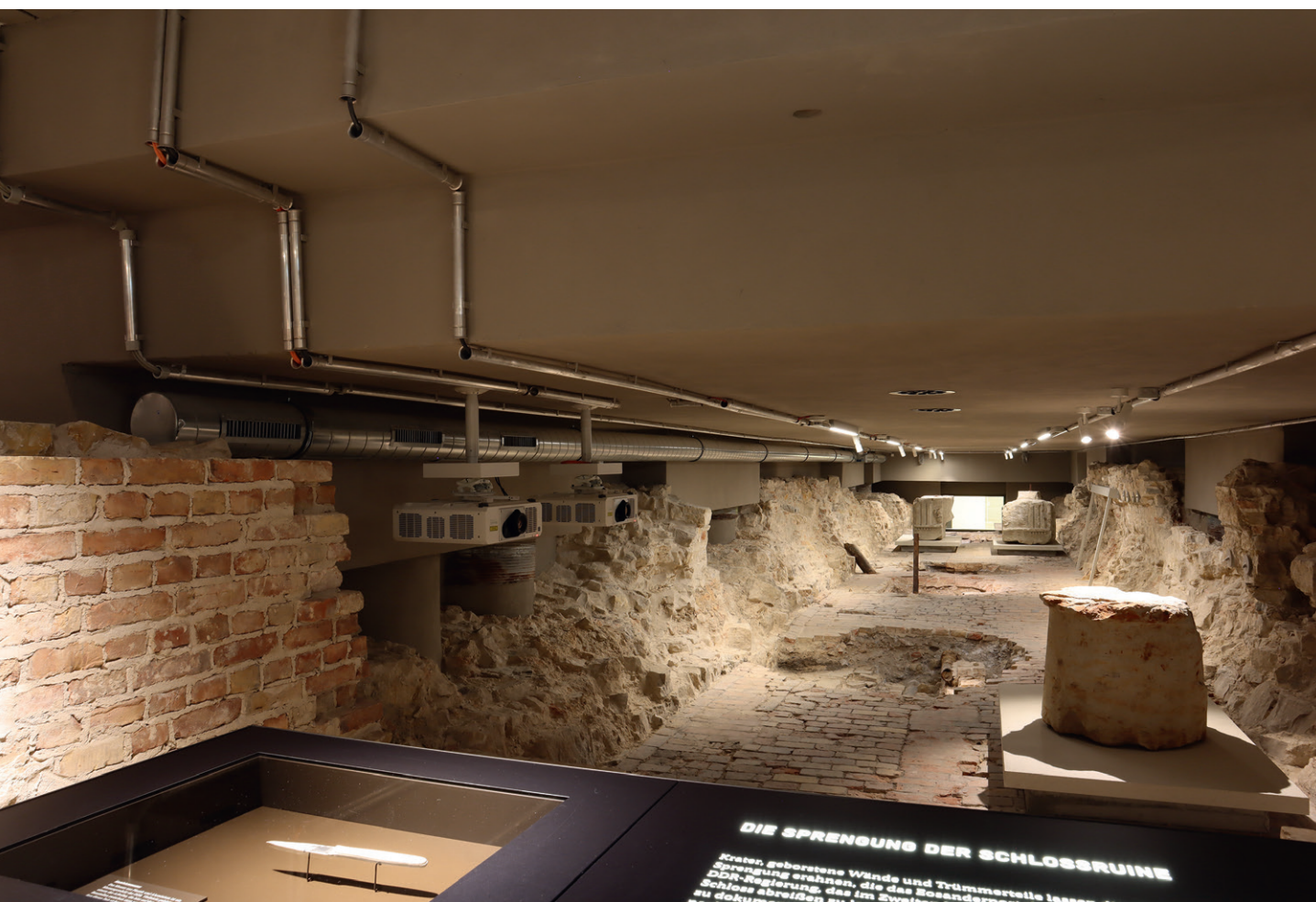
Abb. 11 Zusätzlicher Lüftungskanal im Gang unter Portal III. Foto: U. de Maizière.
