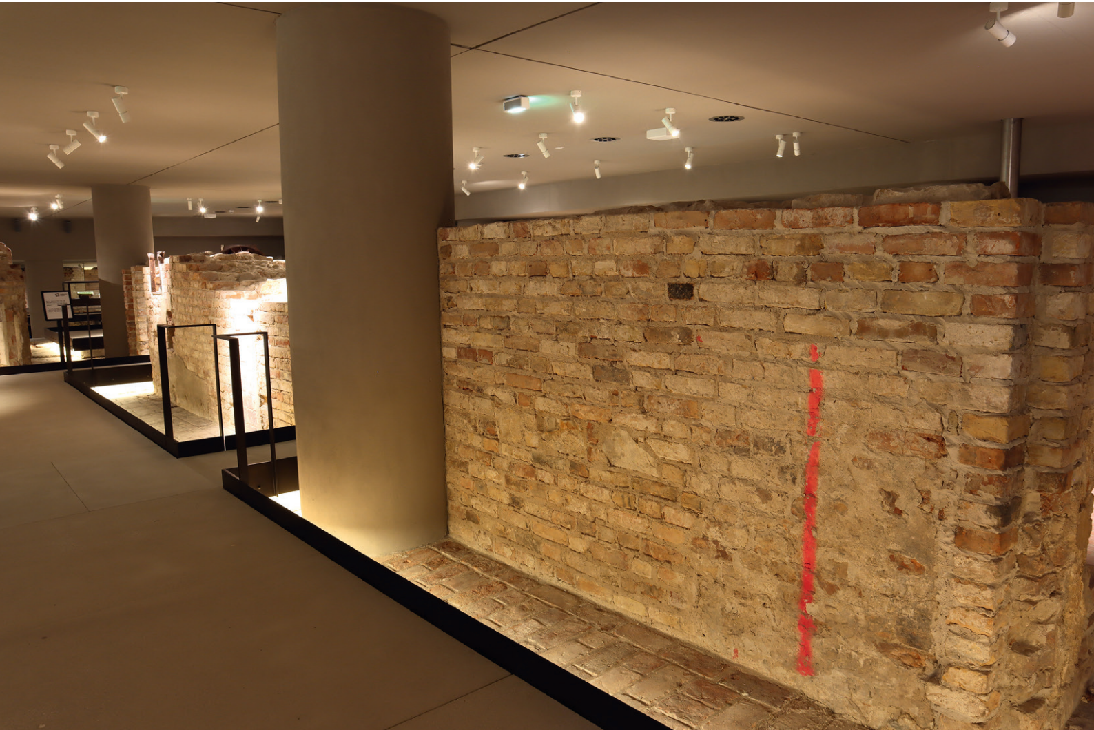
Abb. 21 Ergänzung von Mauerwerk und Ziegelboden im Anschluss an Stahlbetonstütze. Rückgebauter Bereich aus Abb. 6. Foto: U. de Maizière.
