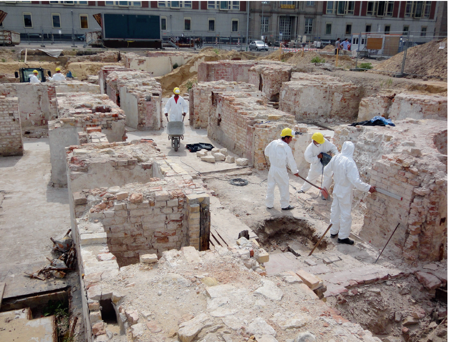
Abb. 6 Rückbau im Bereich einer späteren Stütze. Foto: Franco Stella Projektgemeinschaft (FSPG).
