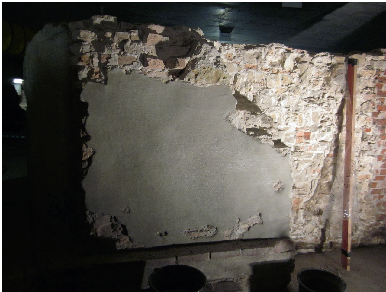
Abb. 14 Der Bereich nach der Putzergänzung. Foto: U. de Maizière.
