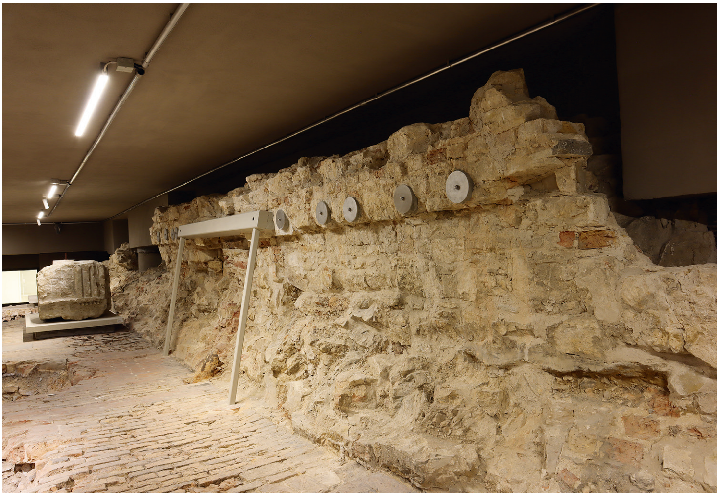
Abb. 16 Abstützung und Verankerung überhängender Bauteile im Gang unter Portal III. Foto: U. de Maizière.
