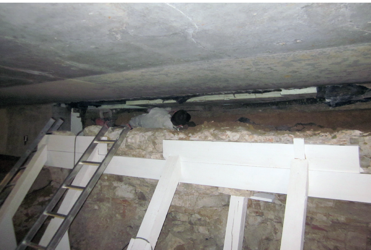
Abb. 10 Arbeiten im Gang unter Portal III zur Abschirmung vertikaler Sandflächen. Foto: U. de Maizière.
