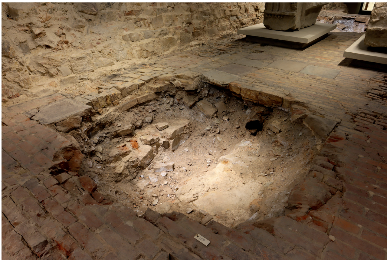
Abb. 17 Stabilisiertes Sprengloch im Gang unter Portal III. Foto: U. de Maizière.
