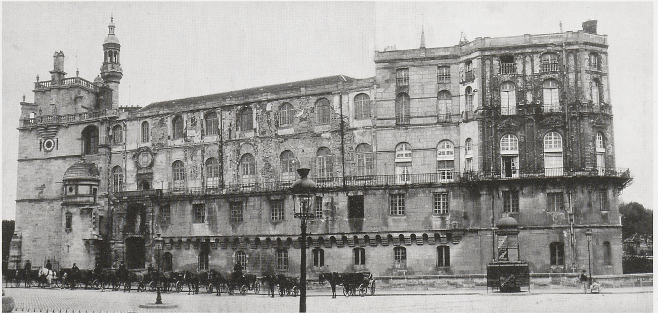
Abb. 4: Die Westfassade des Schlosses um 1867 nach Abriss der Pavillons und der Freilegung der Fassade nördlich des mittelalterlichen Turms. Foto: Charles Marville (1816–1878).
