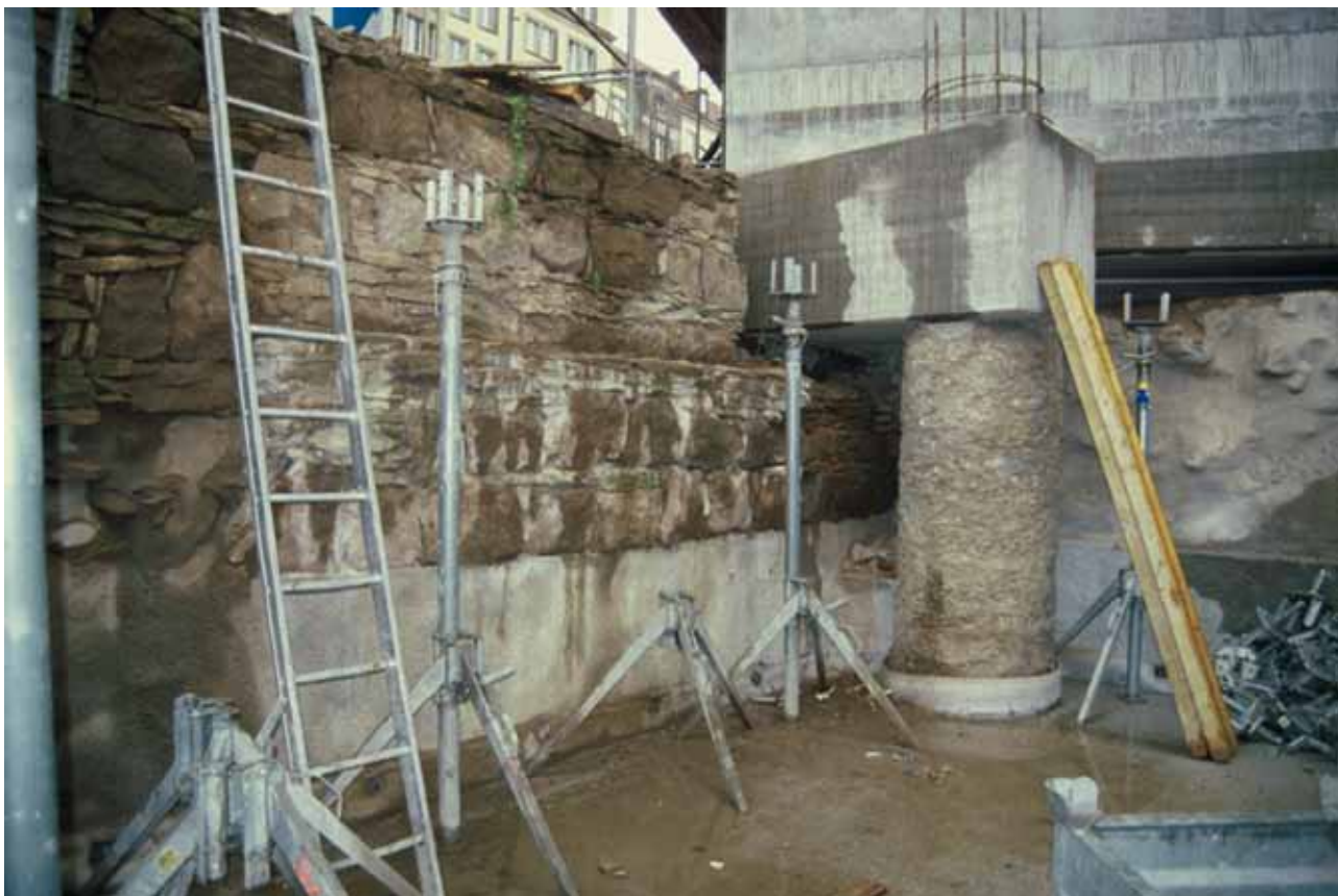
Abb. 4: Die Außenwand des spätmittelalterlichen Kellers Zahnsgasse 5 war gleichzeitig die Baugrenze des Neubaus. Um einen weitestgehende Erhalt dieser Wand zu sichern, waren aufwendige Stützenkonstruktion wie dieser Doppelpfahl mit Balken nötig.
