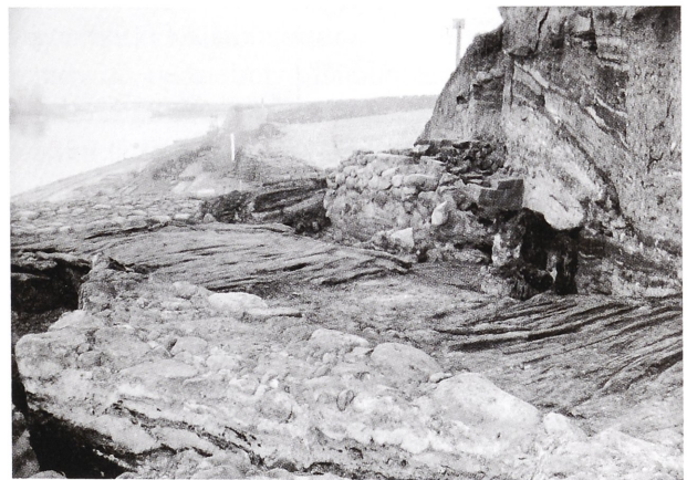
Abb. 10: Blick nach Osten entlang des Südprofils des Hauptschnittes Anfang November 1932. Gut erkennbar sind die Ziegel- und Steinkonstruktionen, die später als Kamin identifiziert wurden. Foto: SMB-PK/MVF, 3079.
