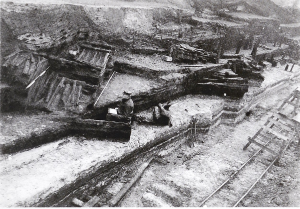
Abb. 15: Reste der Holzkonstruktionen des sog. unteren Schwellroste am Ostwall der Schanze. Möglicherweise handelt es sich bei dem Zeichner um den im Grabungstagebuch erwähnte Ing. Tetens. Foto: SMB-PK/MVF, 3181.
