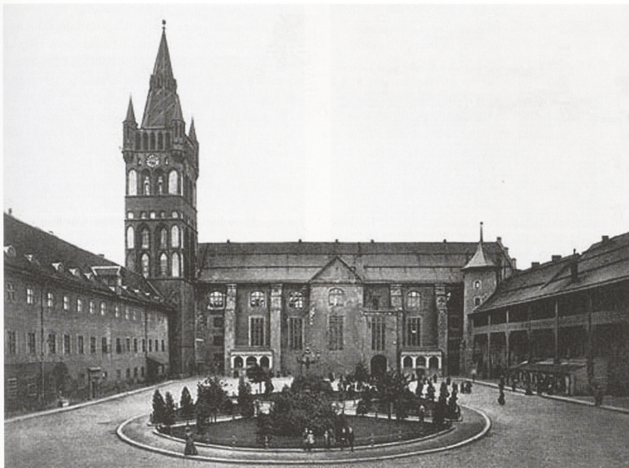
Abb. 1: Innenhof des Königsberger Schlosses, links im südwestlichen Flügel die Ausstellungsräume des Prussia-Museums. Foto: Archiv MVF.
