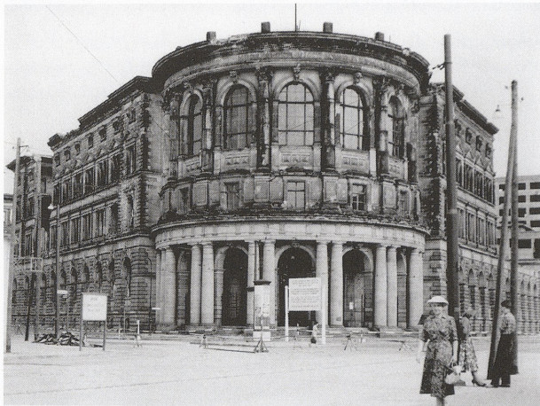
Abb. 8: Das während des Zweiten Weltkrieges teilweise zerstörte Völkerkundemuseum, um 1956. Im Souterrain des teilweise abgetragenen Südwestflügels befand sich die Dauerausstellung, darüber das Depot. Unmittelbar neben dem Gebäude verlief die Sektorengrenze. Vorn rechts im Bild Museumsdirektorin Gertrud Dorka. Foto: MVF.
