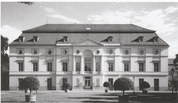
Abb. 9: Langhansbau des Schlosses Charlottenburg, Südfassade, 2004. Der Schriftzug am Gurtgesims über der Eingangstür wurde im selben Jahr angebracht. Foto: Verf.
