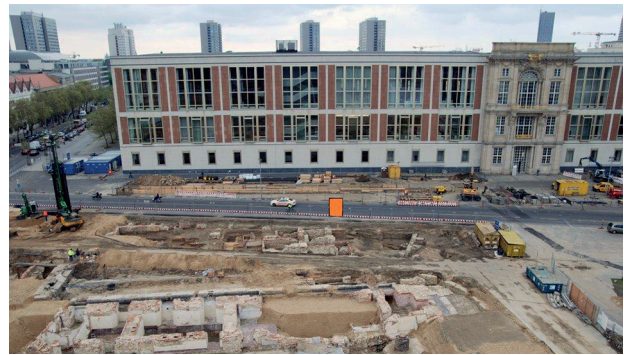
Abb. 9 Teilansicht der Grabungsfläche gegen Südosten. Im Vordergrund die barocken Schlossfundamente, in der Bildmitte Reste des Dominikanerklosters und der Läden westlich davon, im Hintergrund der ehemalige Staatsrat der DDR. Südöstlich der Läden liegt die „Burgsdorff“sche Gruft“ (oranges Rechteck) unter dem Straßenpflaster des Schlossplatzes. Mai 2010. Foto: M. Malliaris.
