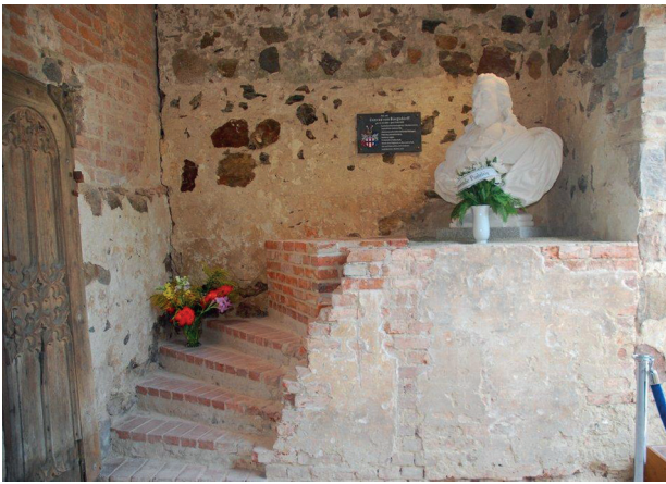
Abb. 10 Blick auf die Treppe des partiell erhaltenen Treppenturms der Kirche von Podelzig. Auf die Treppe aufgemauert ist ein geschlossenes Backsteingewölbe, unter dem die sterblichen Überreste des Konrad von Burgsdorff geschützt liegen. Rechts daneben der Gipsabguss einer Büste des Konrad von Burgsdorff von der sogenannten „Puppenallee“ in Berlin-Tiergarten. September 2014. Foto: M. Malliaris.
