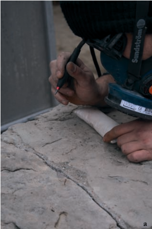
Abb. 3: a) Microsandstrahltechnik, b) Microdampftechnik in der OPUS Denkmalpflege GmbH Werkstatt. Foto: T. P. Otto.
