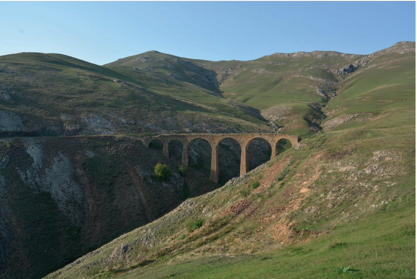
Abb. 3 Viadukt der ehemaligen Bergwerkseisenbahn zwischen Qalakənd und Gədəbəy. © Foto: M. Gruber.
