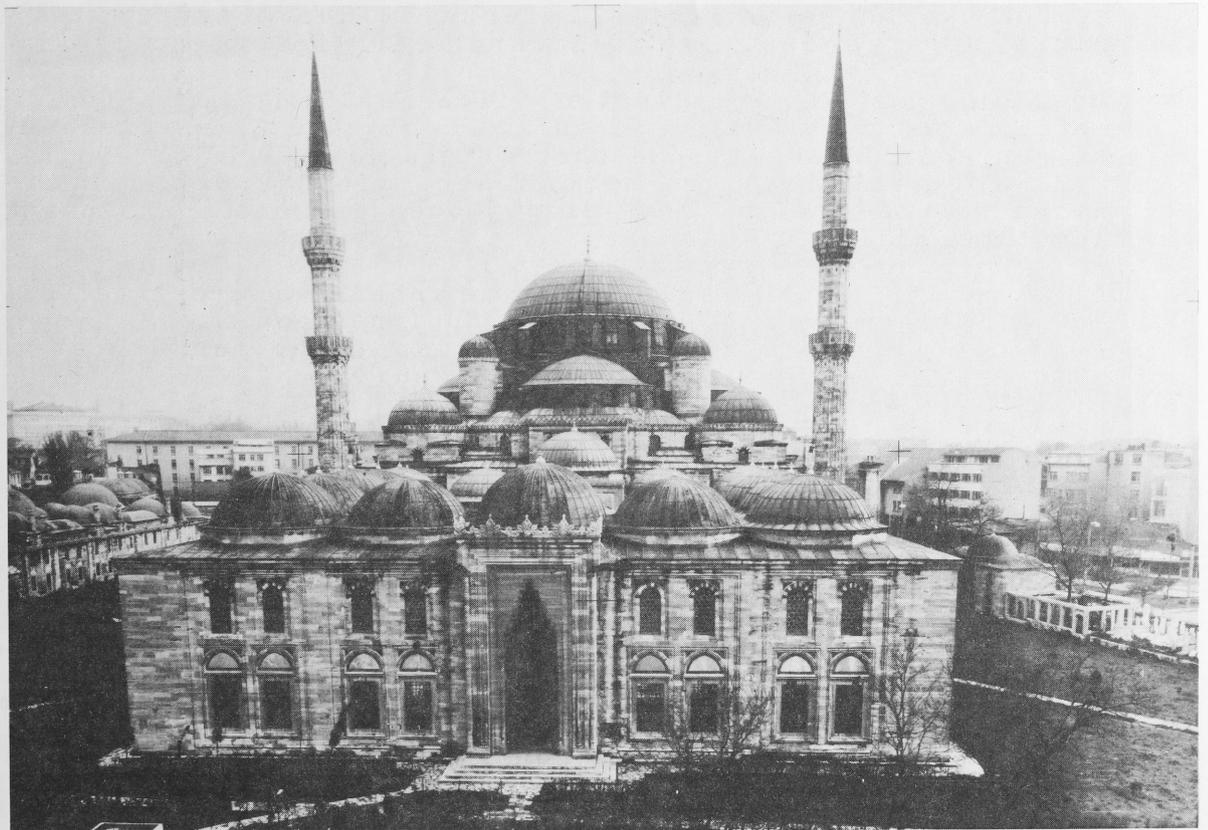
Abb. 4: Meßbild zu Abb. 3. Aufnahme hier mit WILD P 32 auf Film. Die Kamera ist mit einem weitmaschigen Reseau zur Erfassung von Filmunebenheiten usw. versehen.
