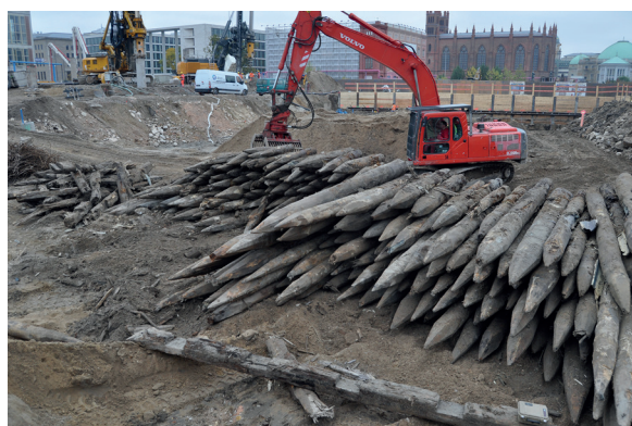
Abb. 2 Kiefernpfähle aus der Gründung des Berliner Schlosses, die für die Versteigerung 2013 vorgesehen waren (Aufnahme: Michael Malliaris, Verbleib der Aufnahme: Landesdenkmalamt Berlin).
