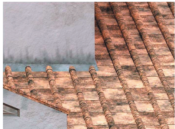
Abb. 5 Auch im 3D-Modell sollten Bauteile nicht stumpf ineinander laufen, sondern mit dem entsprechenden baulichen Detail verbunden sein. (© 2002-2006 ArchimediX)
