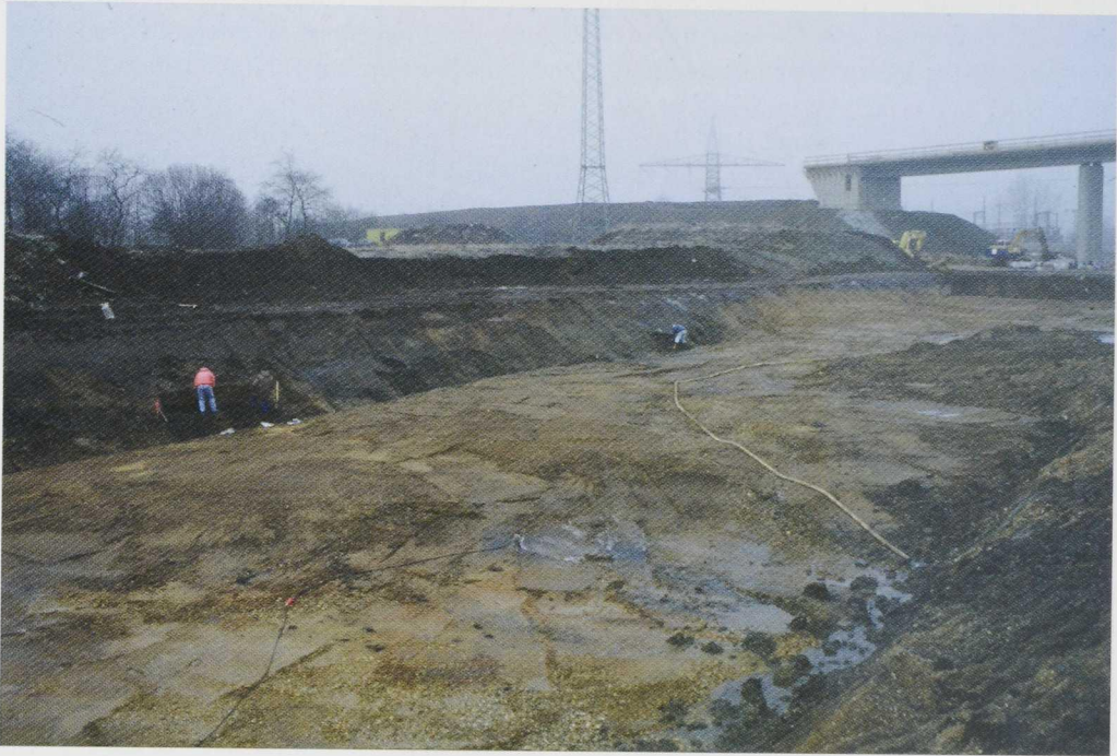
Abb. 2 Greding-Großhöbing, Lkr. Roth, Fl.-Nr. 256/259. Freilegung hölzerner Baubefunde im Bereich und an der Basis der mehrere Meter mächtigen Hochflutlehme. (Foto: M. Nadler).
