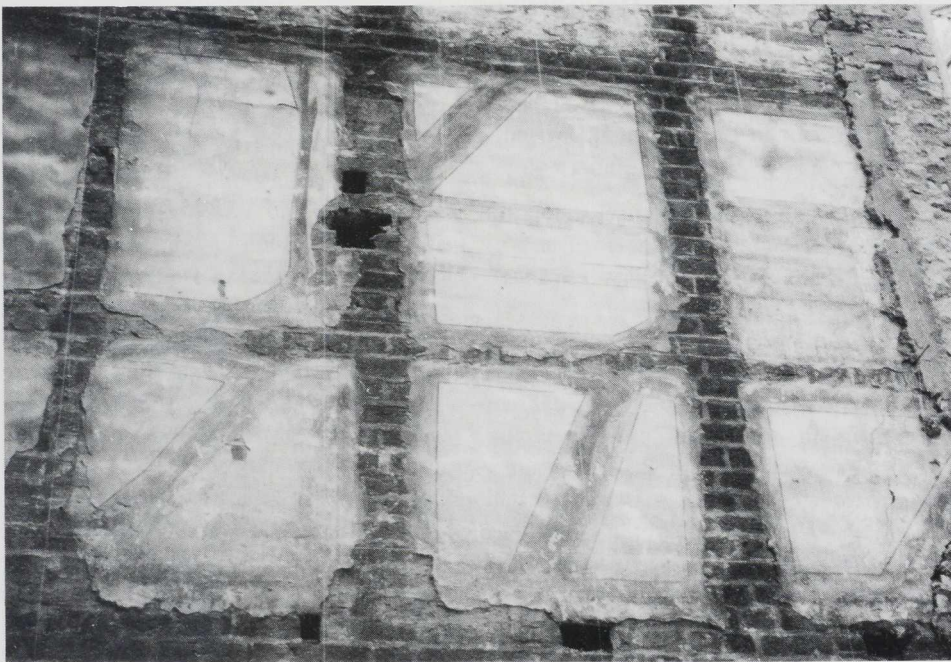
Abb. Leipzig, Hainstraße 12. Giebelwand zur Nachbarparzelle Nr. 10 mit illusionistischer Fachwerkbemalung. Gesamtansicht (oben) bzw. Detail (unten).
