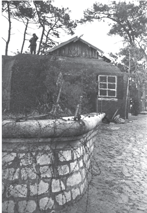
Abb. 35 Ein getarnter Bunker des Atlantikwalls (1943): auf die Betonwand wurde ein Fenster aufgemalt sowie ein Holzdach aufgesetzt, um den Eindruck eines Wohnhauses zu erzielen. Die Betonmauer im Vordergrund wurde als Feldsteinmauer bemalt (Bundesarchiv, Bild 101I-263-1578-10 / Fotograf: Wette).
