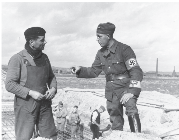
Abb. 32 Auf einer Baustelle des Atlantikwalls in der Bretagne (1942): ein Angehöriger der Organisation Todt, erkennbar an dem Schriftzug auf der Armbinde, gibt einem französischen Arbeiter Anweisungen (Bundesarchiv, Bild 101II-MW-2355-10 / Fotografen: Kraupa; Tuskany; Duskamp).
