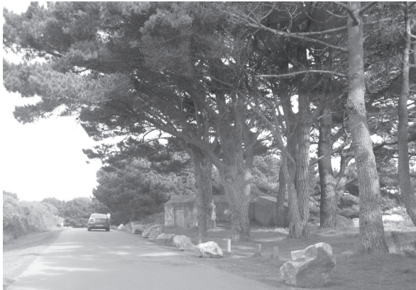
Abb. 34 Der deutsche Bunker an der Strandstraße von Kerpenhir dient heute nur noch den Touristen als Kletterobjekt. Der größte Teil befindet sich im Erdboden (Foto: R. Perschke, Aufnahme 2012).
