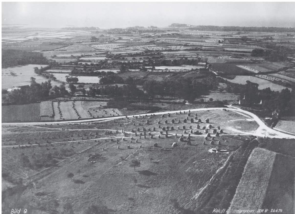
Abb. 14 Luftbild vom westlichen Ende der Steinreihen von Kermario (Anblick aus Norden) mit Freigabevermerk des Reichsluftfahrtministeriums. Im Hintergrund die nahe Atlantikküste (APU – Bestand Hülle/Kerlecsan).
