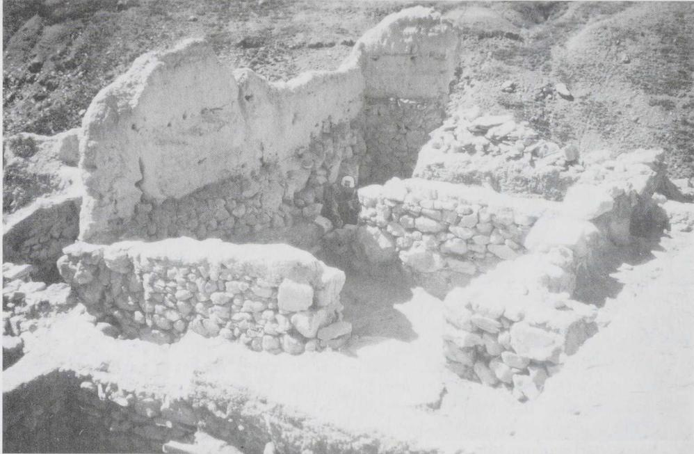
**Abb. 6** Hausruine in Mebrak während der Grabung 1993. Trockenmauern mit einer erhaltenen Stampflehmauflage von etwa 1m Höhe.
