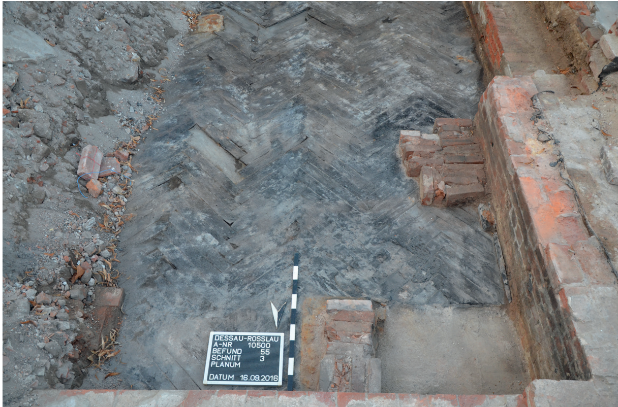
Abb. 8 Dessau. Im Keller des im Krieg zerstörten Hauptgebäudes der Anhalt-Dessauischen Landesbank fand sich ein Raum mit hochwertigem Parkettboden, der im Rahmen der Nutzung als Luftschutzraum durch eine Lage Ziegelsteine geschützt wurde (Foto: M. Freudenreich, LDA).
